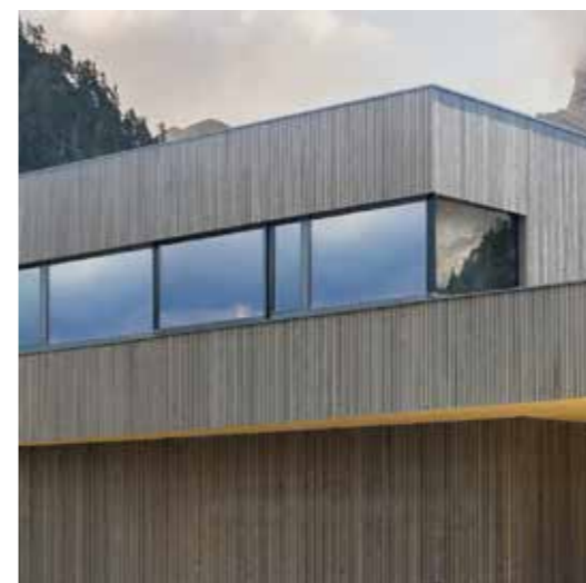
○ Montage einer vorvergrauten Fassade im Jahr 2017
